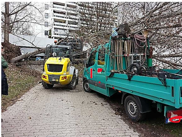
Sturmschaden 2015, Orkan Niklas, Pappel auf den LKW gefallen
