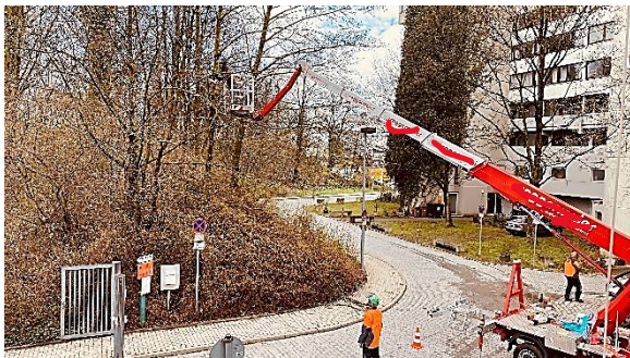
Baumpflege zur Totholzbeseitigung an begangenen Flächen
