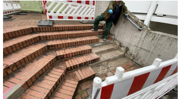
Maurer beim Auswechseln der Treppenklinker
