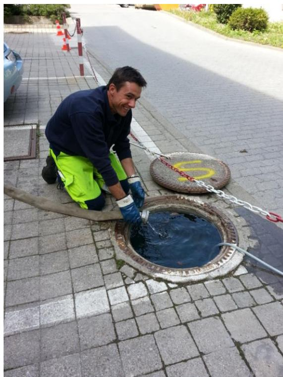
*Auch die zahlreichen Schächte mussten bis oben hin abgedichtet werden. Ein spezielles Verfahren sparte einen fünfstelligen Betrag ein. Hier eine Dichtheitsprüfung.*
