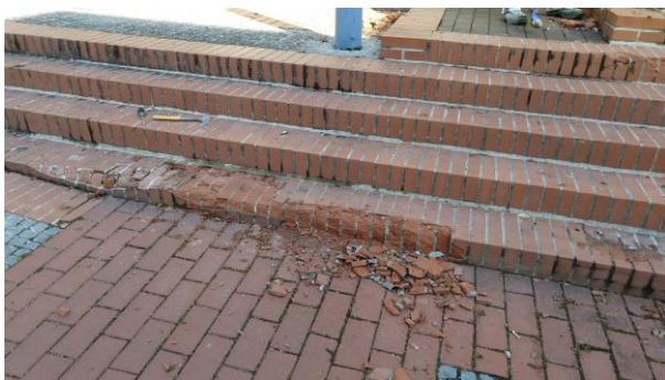
Abgeschlagene und lockere Stufenvorderkanten.
