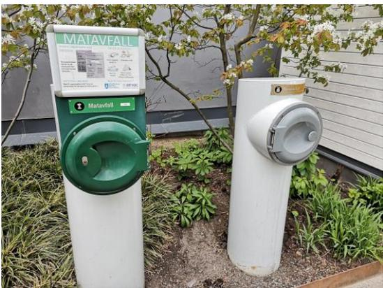
*Der Biomülleinwurf ist hier abgeschlossen, um Fehleinwürfe zu vermeiden.*
