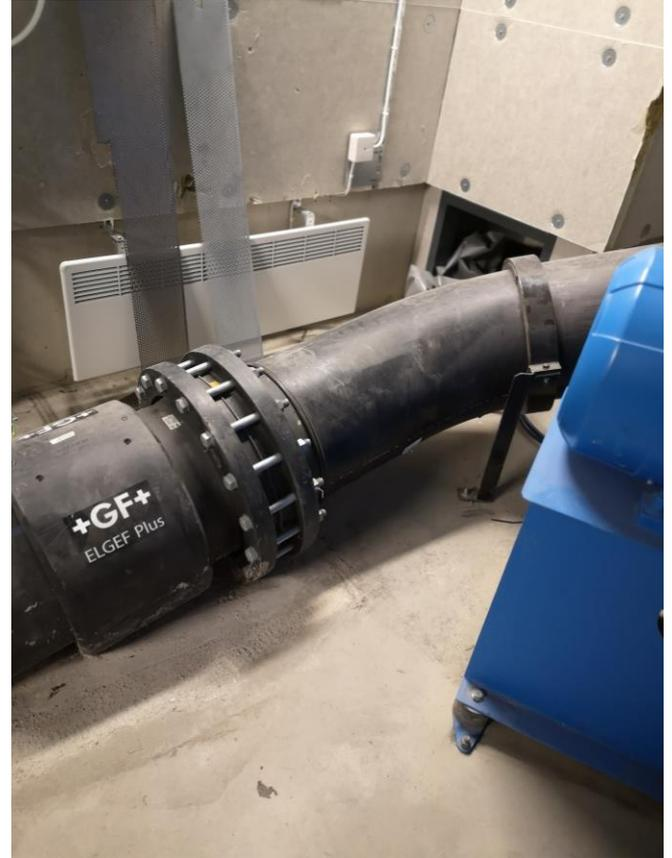
*Kunststoffleitung für Optibag System im Versuch*
