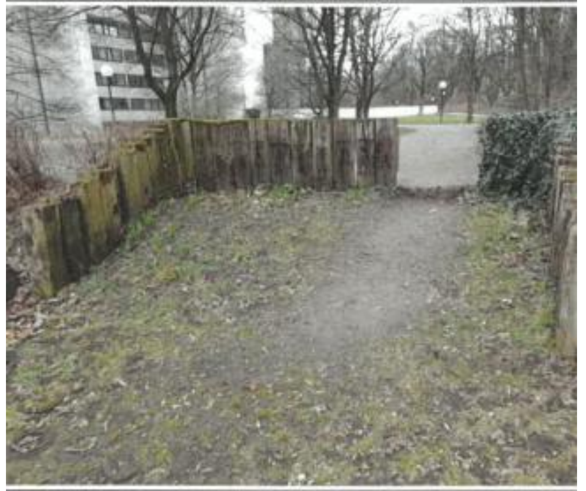
Materialprobe BSP1, eckige Hölzer, westlicher Bereich des Spielplatzes
